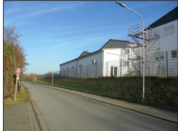
Abb.11: Ehemalige gewerbliche Nutzung östlich der Berliner Straße (nördliches Plangebiet) und Straßenbegleitgrün.
