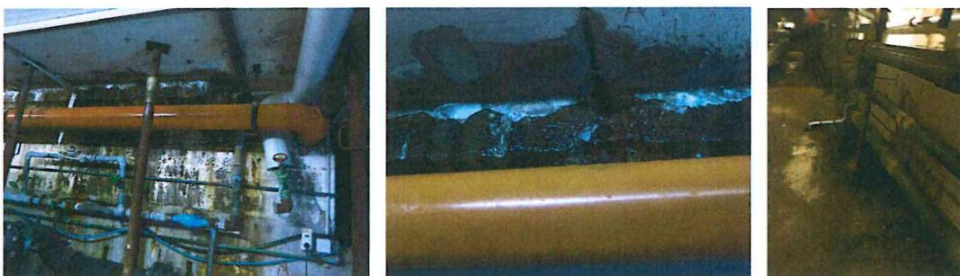
**Bild 19 – 21:** Undichten des Beckens und Beckenumganges mit entsprechenden Betonschäden
