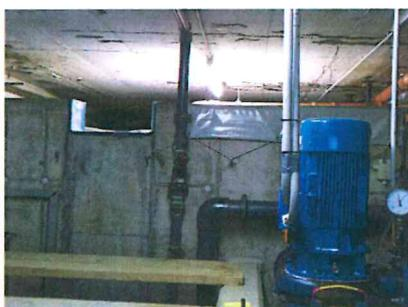
**Bild 18:** Rohwasserspeicher mit Umwälzpumpe
