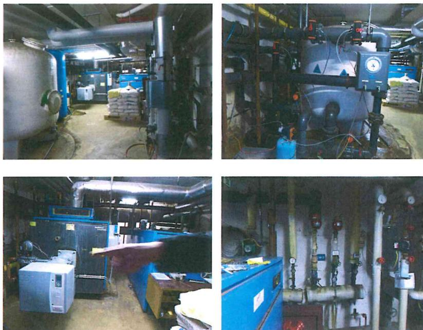
**Bild 14 - 17:** Heizkesselanlage mit Warmwasserbereitung und Filteranlage
