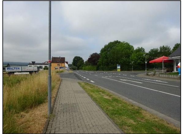
Abb. 6: Einmündungsbereich zur Rheinfelser Str.
