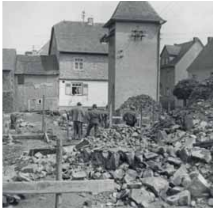
Die Überreste von Backhaus und Spritzenhaus
