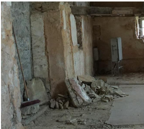
Der Innenraum der Kirche vor der Restaurierung
