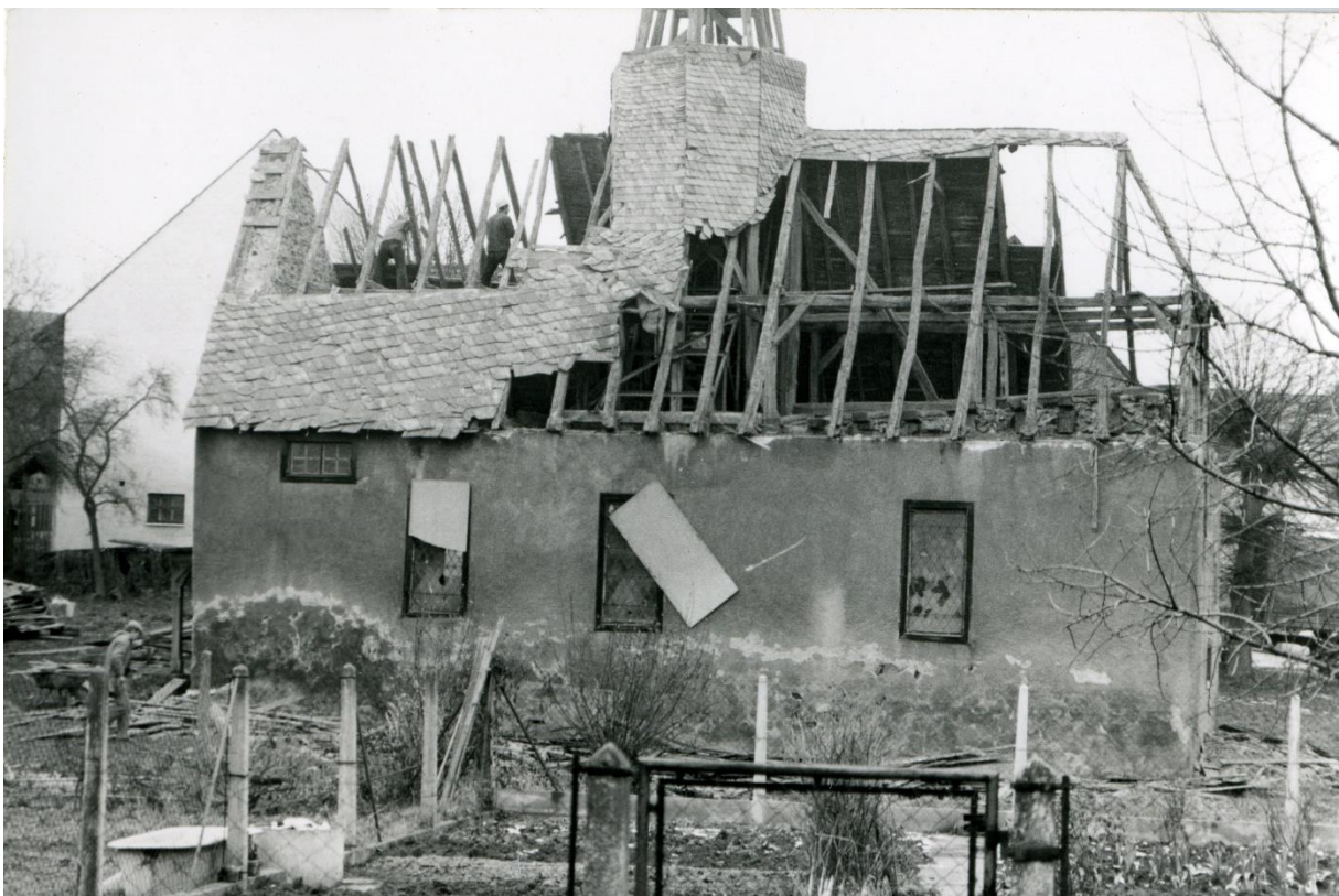
Abbruch der Kirche in Volpertshausen im Dezember 1980
