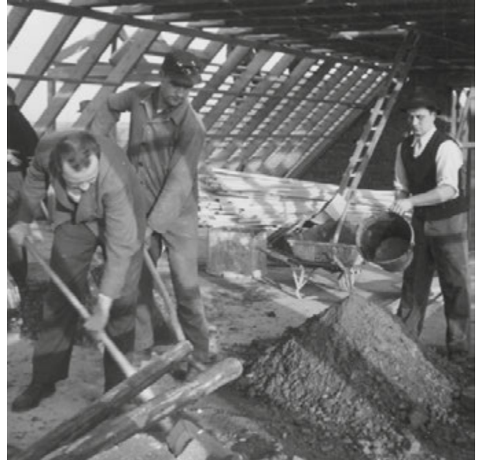
Für die letzten Maurerarbeiten müssen mit einem Flaschenzug Wasser und Mörtel bis nach oben gezogen werden.
