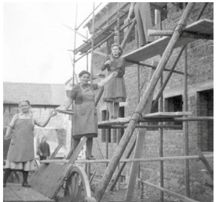
Beim Dachdecken sind auch die Frauen im Einsatz. Hier reichen sie in einer Kette die Ziegel nach oben. Auf dem Gerüst stehen in der Mitte Marie Höhler und rechts Elfriede Olms.
