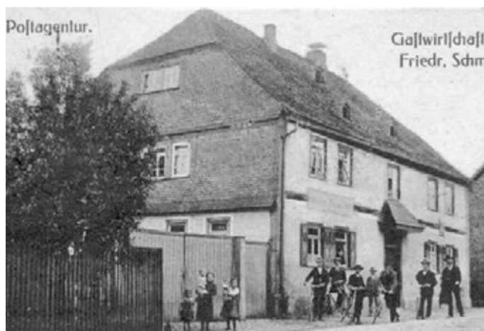
„Faalseibe“ (Familie Seipp am Falltor) bewohnten das ehemalige Gasthaus „Zur Post“ in der Frankfurter Straße 65a in Groß-Rechtenbach
