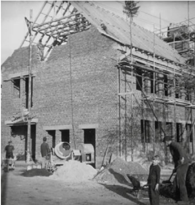
Nach weniger als einem halben Jahr Bauzeit kann im Oktober 53 schon Richtfest gefeiert werden.
