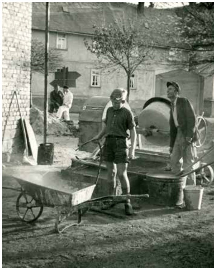
Auch Kinder und Jugendliche helfen eifrig beim Bauen mit. Der Heimatvertriebene Herr Blaschke (rechts im Bild) wirft einen begeisterten Blick auf das Bauwerk.
