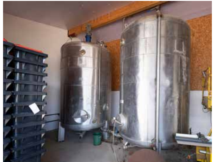
Anschließend werden sie in die beiden Edelstahlbehälter (Hygienisierungsanlage) gepumpt und dort erhitzt.
