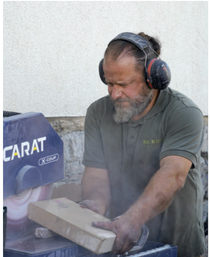
Die neuen Steine für den Backofenboden macht der Meister passend.
