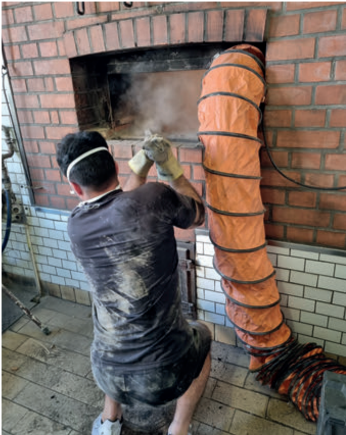
Es staubt gewaltig, als Sahil Nizaret den alten Boden aufstemmt. Foto: K.-H. Weber
