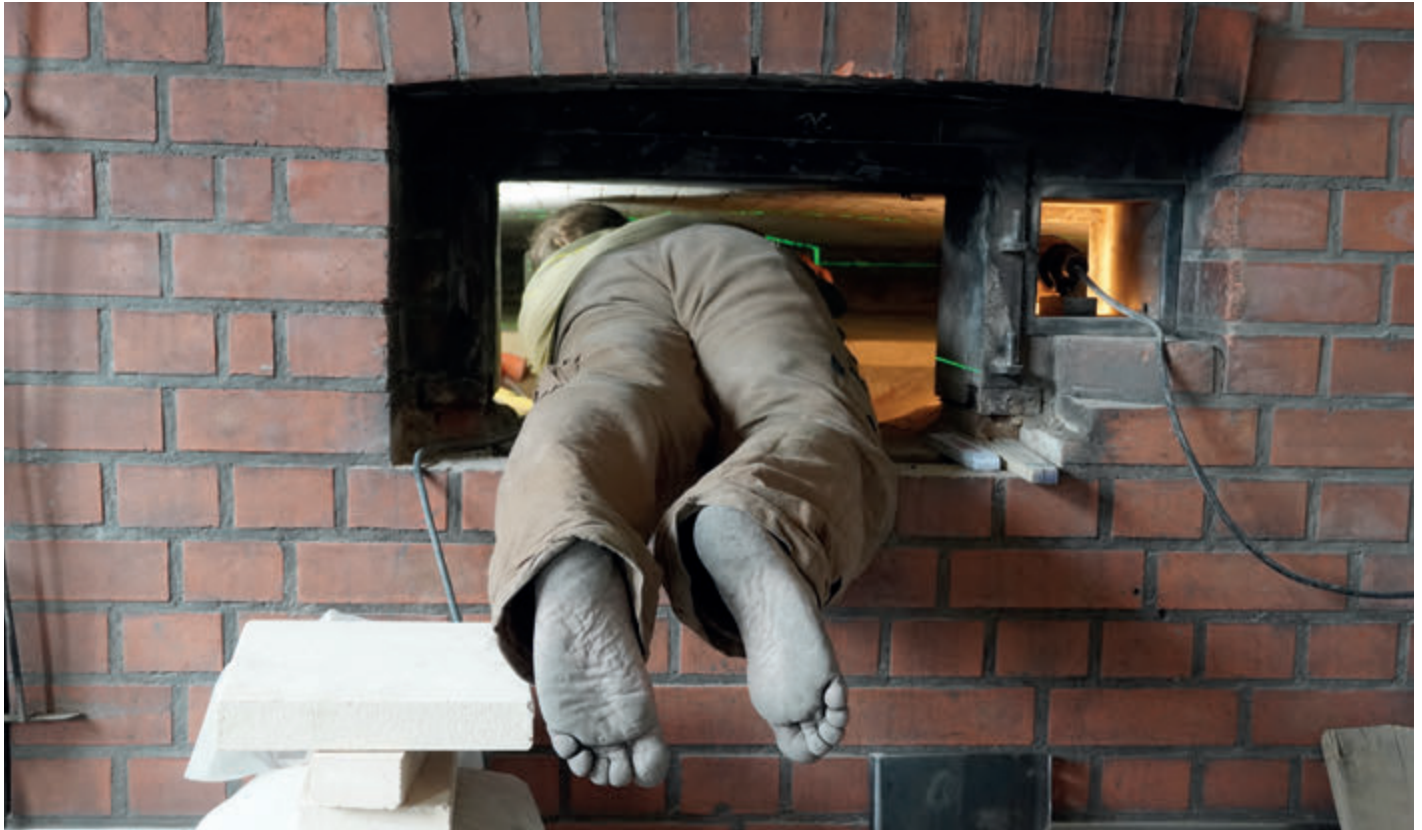
Voller Körpereinsatz in drangvoller Enge: Nur die Füße hängen raus, als Backofenmeister Daniel Reisinger im „Onnelenner Backhaus“ in Hochelheim den rissig und brüchig gewordenen alten Boden des Backofens gegen einen neuen austauscht. Fotos (3): Michael Breuer
